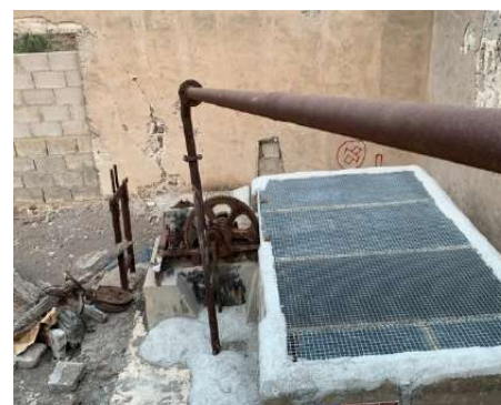
Fotografías del pozo. Estructura exterior sin techumbre y mal estado. Interior con motor original oxidada y en estado de abandono.
