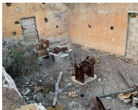
Fotografías del pozo. Estructura exterior sin techumbre y mal estado. Interior con motor original oxidada y en estado de abandono.
